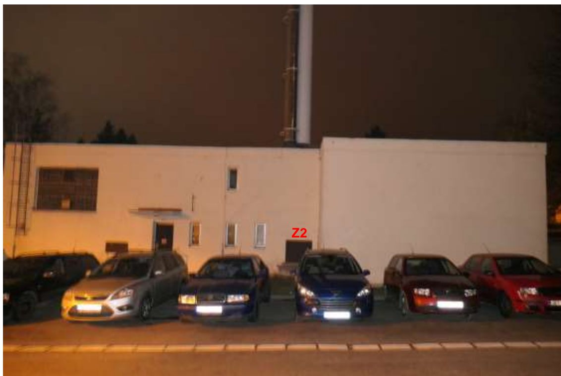
Obr. 4 Pohled na Z2 – žaluzii sání do prostoru kotelny, V fasáda
