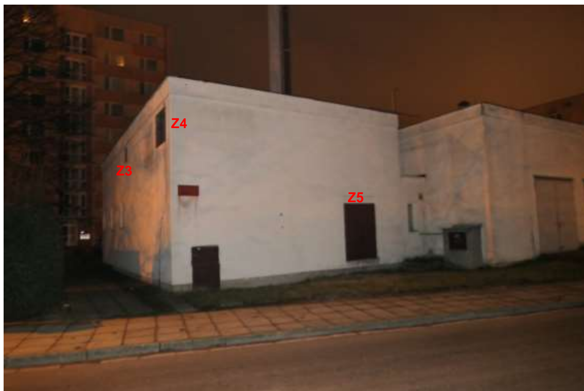
Obr. 5 Pohled na zdroje Z3-Z5, žaluzie výtlač, nouzový ventilátor a vrata kotelny, S a Z fasády
